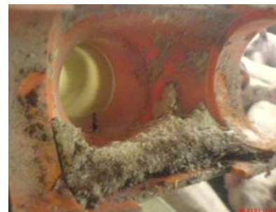
Verunreinigung in einem Ablauf
