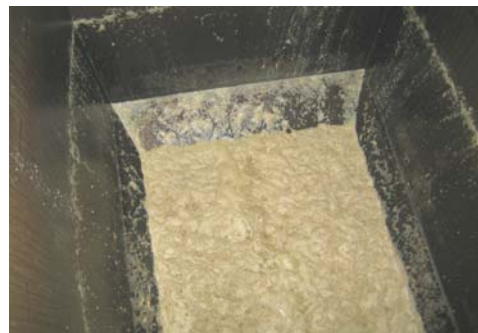
zu hoher Restfuttergehalt im Brauchwassertank
